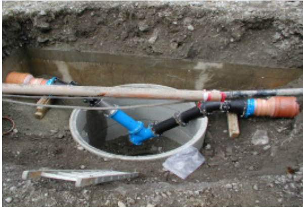
Abbildung 1: Induktive Durchflussmessung Alfutzquelle
