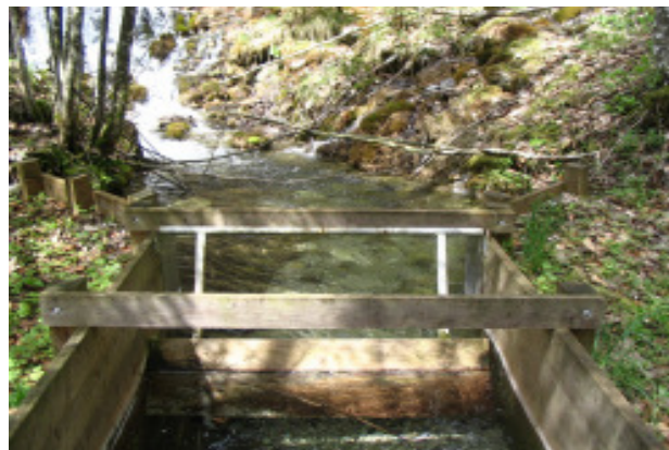
Abbildung 5: Wellenberuhigungsvorrichtung
